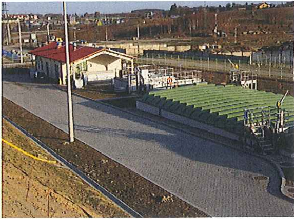
Podczyszczalnia ścieków i odcieków
