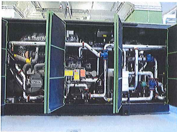
Bioelektrownia – Kogenerator
