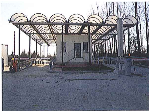
Budynek obsługi wag
