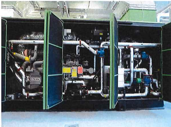
Bioelektrownia – Kogenerator
