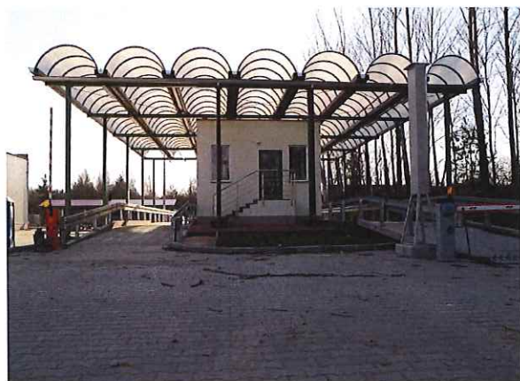
Budynek obsługi wag
