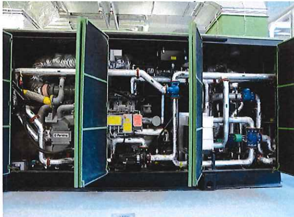
Bioelektrownia – Kogenerator
