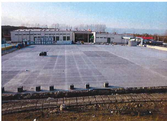
Budynek sortowni i kompostowni
