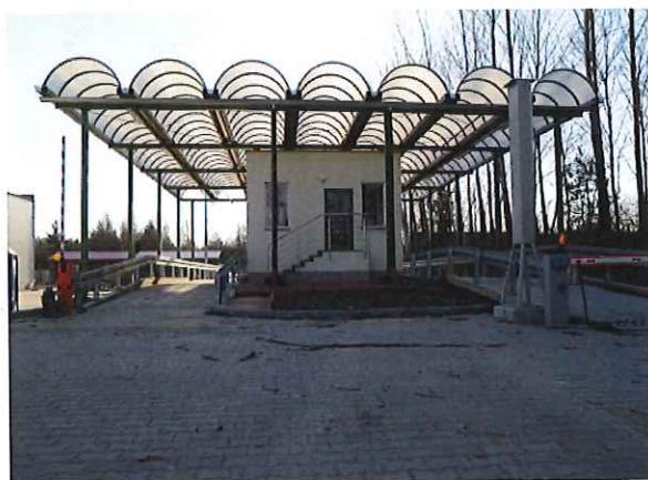
Budynek obsługi wag
